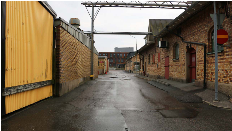
Vy mot söder i områdets östra del. Sluten karaktär där ursprunglig bebyggelse möter tillbyggnader från olika skeden.
