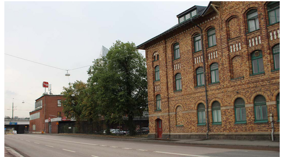
Slakthusområdet sluter sig också mot norr och Slakthusgatan. Huvudentréns byggnader, raden av äldre träd och charkuterifabriken utgör en front mot omgivande stadsrum.
