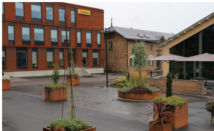
Kontorshusets fasad med cortenplåt möter upp den ursprungliga bebyggelsen. Platsen har ett samtida uttryck med mobila planteringar.
