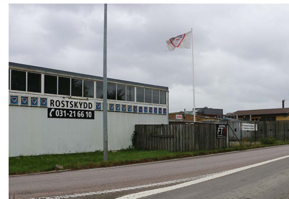
I den västra delen av området, närmast Marieholmsle utgörs bebyggelsen av verksamheter som inte har koppling till livsmedelsproduktion och har tillkommit under senare tid.
