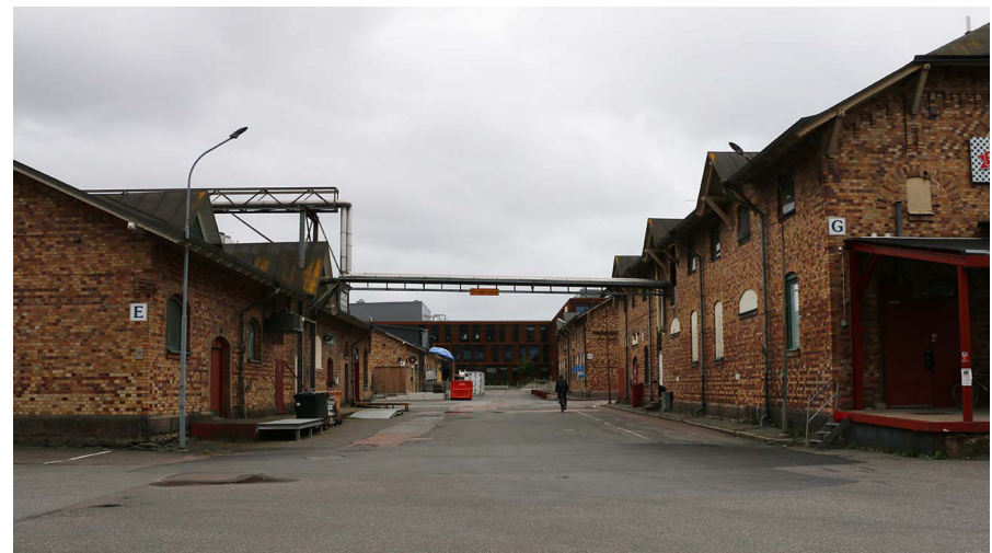
Vy mot söder i områdets västra del. Stråket genom området i nordsydlig riktning visar på den slutna karaktären i områdets centrala delar och hur bebyggelsen i områdets inre avslutas med tvärställd bebyggelsen i norr och söder.
