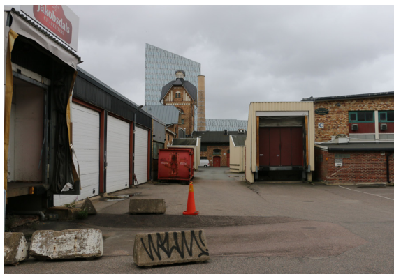
Bebyggelsens årsringar berättar om livsmedelsindustrins utveckling i området. Tillbyggnader från 1960-talet har anpassats vad gäller färg och material och är visuellt underordnade. På andra ställen kan tillbyggnaderna vara mer dominerande.
