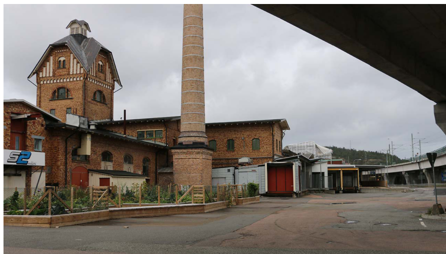
Besökare som kommer från Gammelstads torg möter idag "Slaktarens trädgård". Den nya stationen har medfört att ingången från Waterlooogatan har fått en större betydelse som entré till Slakthusområdet.
